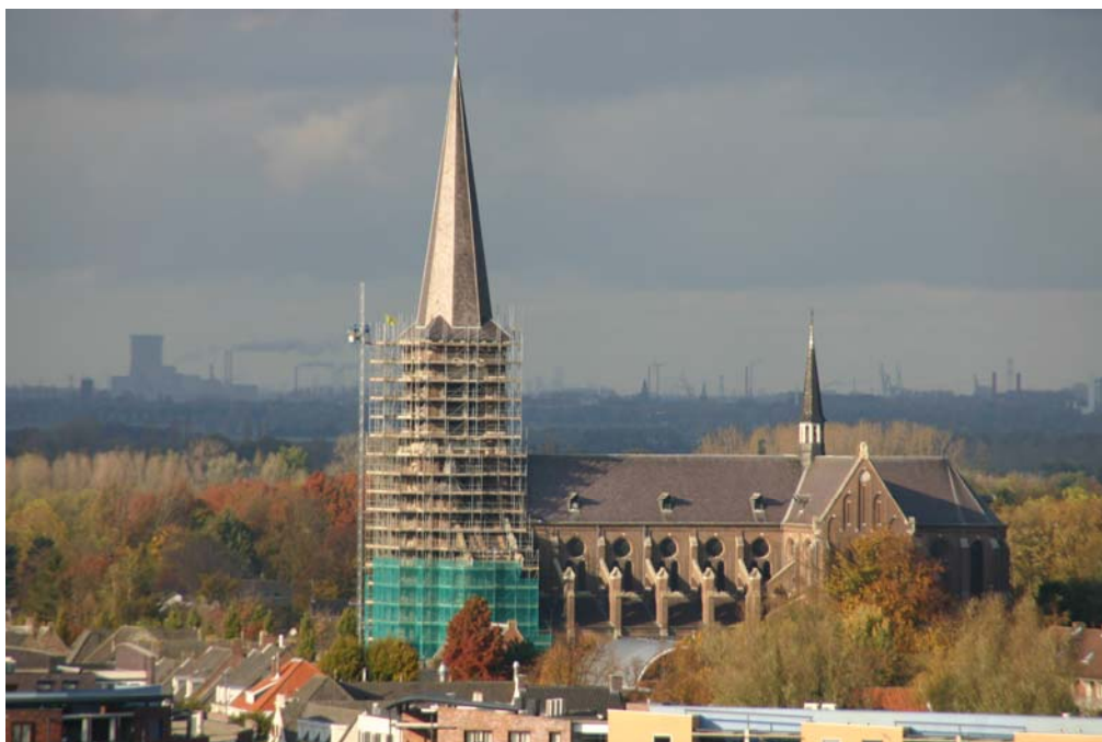
ROP-restauratieproject Lambertuskerk te Etten-Leur
