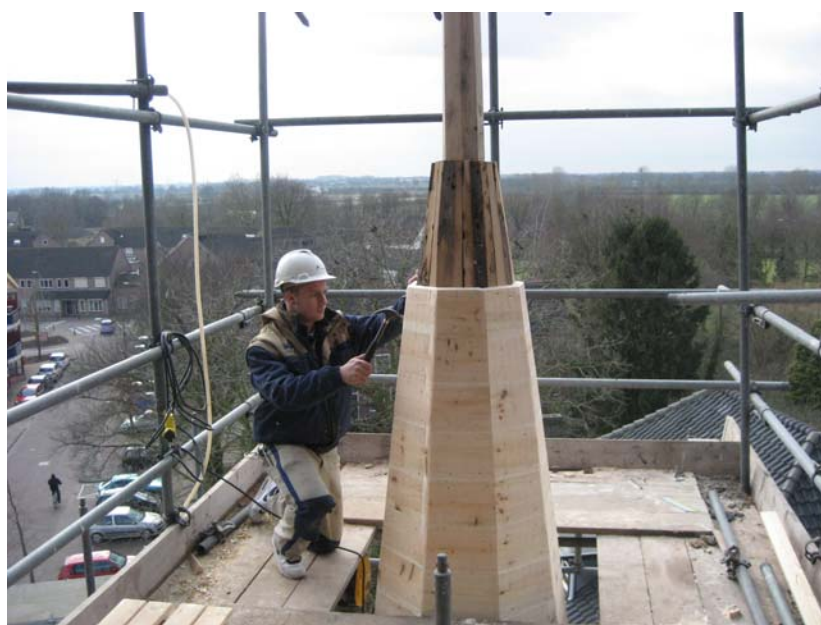
ROP- restauratieproject Martinustoren te Gennep
